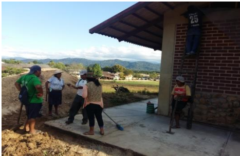
Die Kirche von Aroma wird von innen und aussen gut renoviert.
