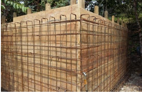
Wassertank im Bau. Das Wasser sprudelt aus allen Hähnen.
