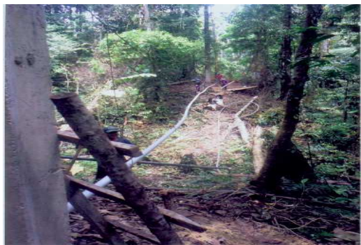
Rohrleitungen verlegen , bedeutet manchmal Hindernisse überbrücken.
